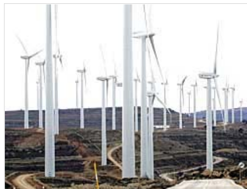
Unos aerogeneradores instalados en un parque eólico de la Comunitat.
